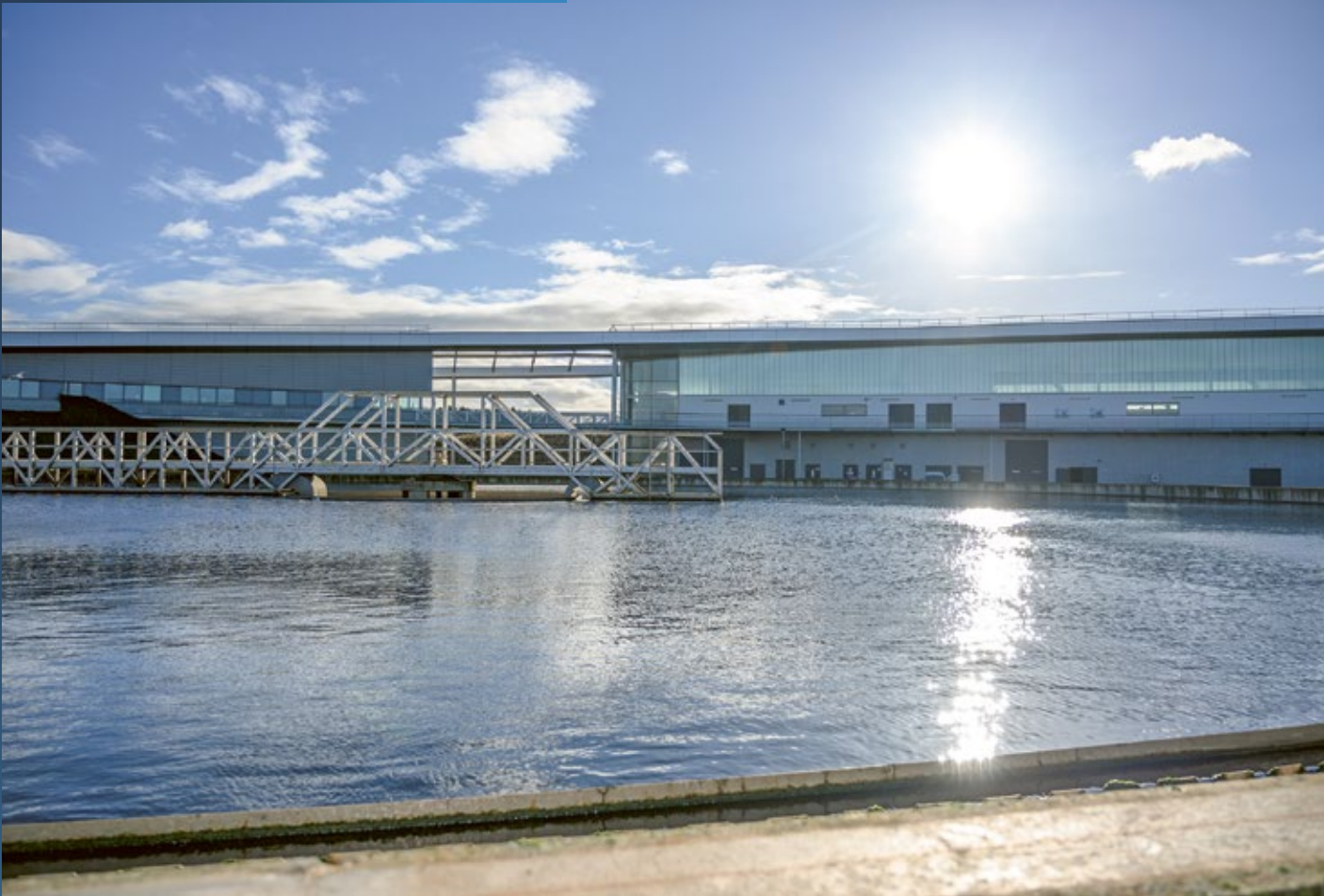
« Nous avons lancé les études nécessaires pour mettre en œuvre le plus rapidement possible cette optimisation de la réutilisation des eaux « grises » de la station d'épuration. »
