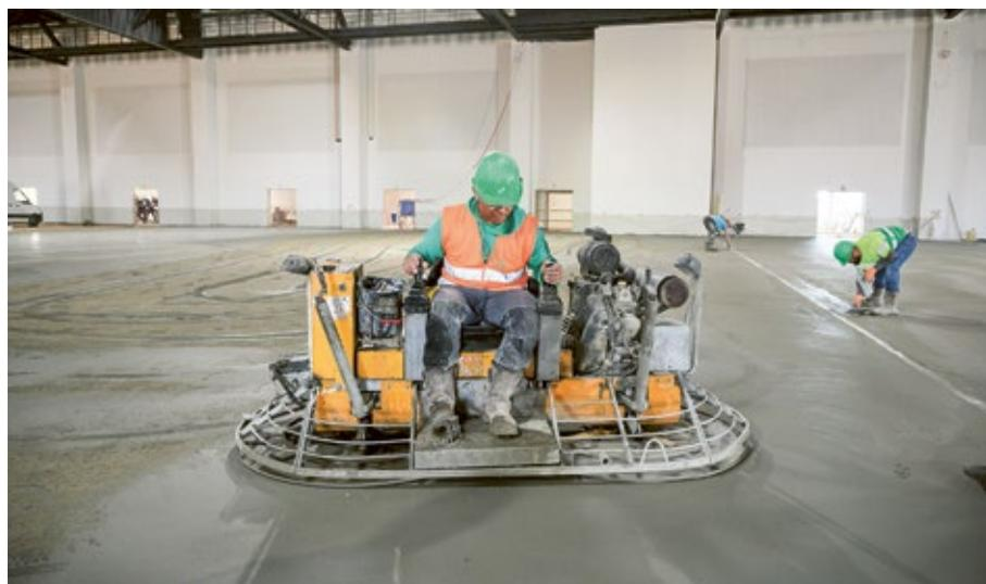
En fin de journée, quelques heures après le coulage, les compagnons talochent le béton à l'aide d'un appareil appelé « hélicoptère », doté d'un système de pales qui permet de lisser la surface.
